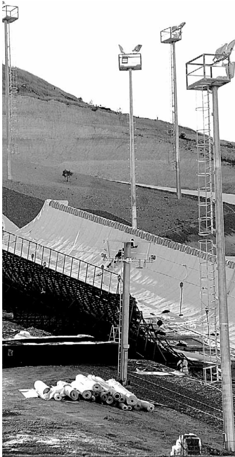
Obras de construcción de la pista de esquí de Villavieja. / F. JIMÉNEZ
