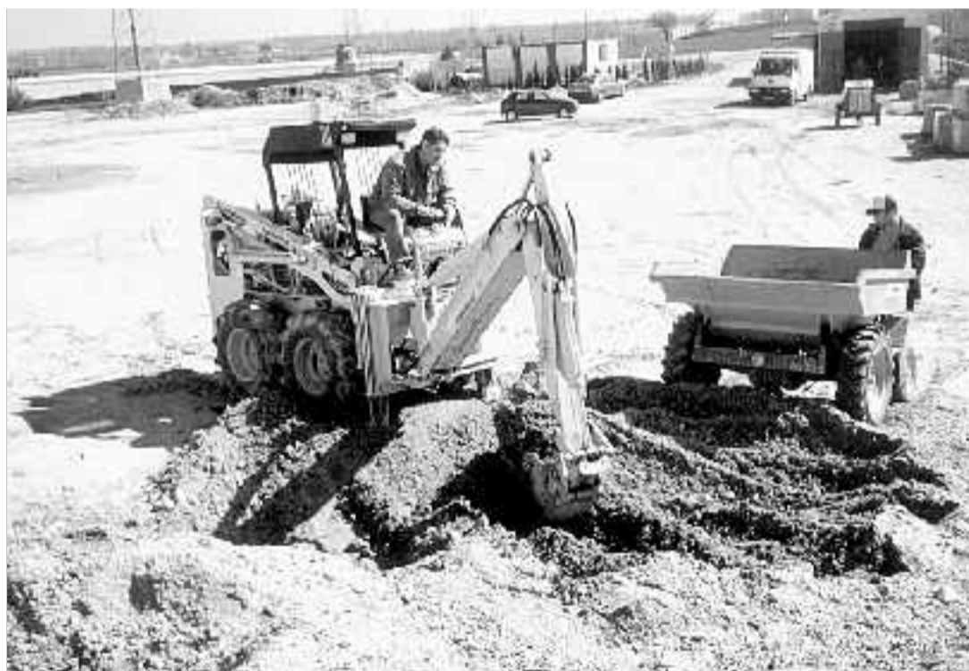
La pequeña máquina multiusos durante la realización de trabajos de excavación. FOTO F. ZAPATERO
